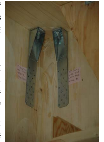
2階壁パネル頭部ホルダダウン金物
