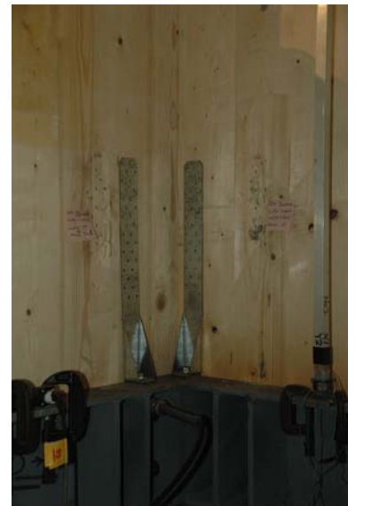
1階壁パネル脚部ホルダダウン金物
