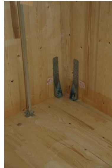
2階壁パネル脚部ホルダダウン金物
