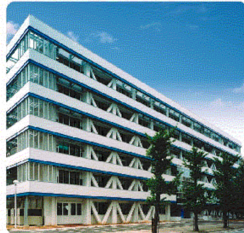
施工例/名古屋工業大学総合研究棟(2002年3月施工)
